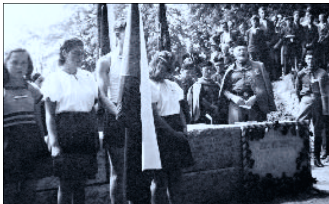
Slavnostní položení základního kamene nové sokolovny 22. 6. 1947
