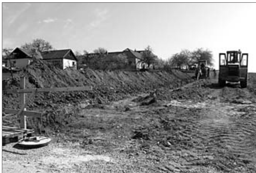
Výstavba kanalizace a ČOV v Ohrazeníčku, rok 2007
