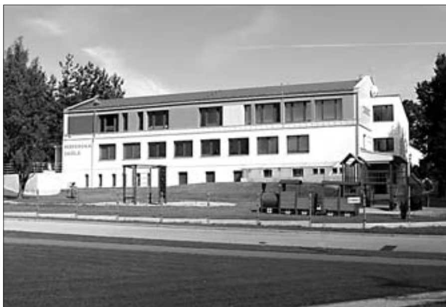
Zrekonstruovaná a přistavěná budova MŠ, rok 2010
