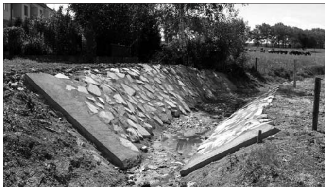
Opravená I. část obtokového kanálu
