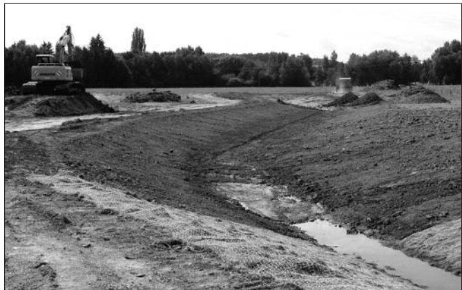
Výstavba II. etapy obtokového kanálu
