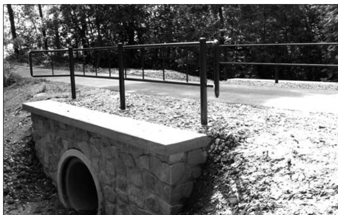
Opravený silniční propustek u Sv. Voršily
