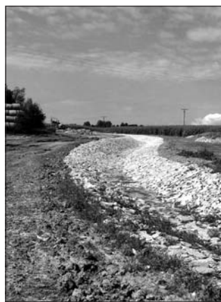
Výstavba II. etapy obtokového kanálu
