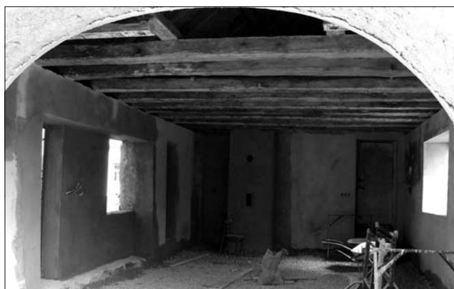
Oprava hasičské zbrojnice v Zalinech
