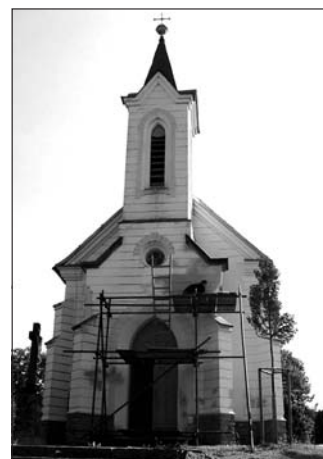
Oprava kaple v Zalinech
