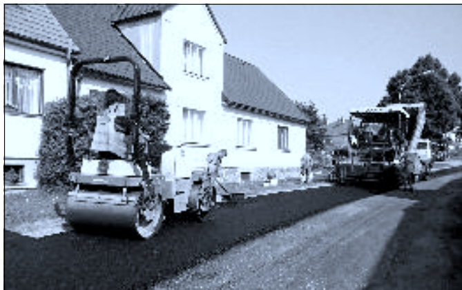
Vyasfaltování části ulice 5. května
