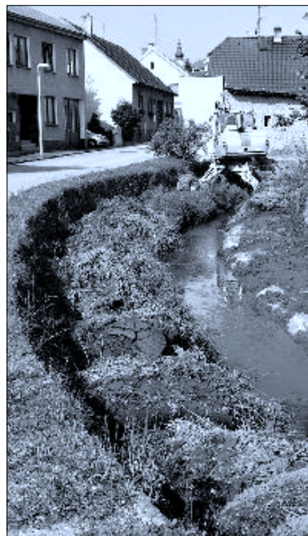
V Lazenské ulici byl vyčištěn nejvíce zanesený úsek koryta Spolského potoka.
