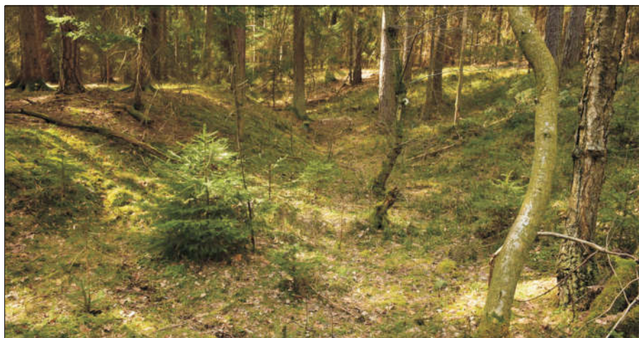
Zářez koryta spojovacího kanálu (obvodové strouhy) pod rybníkem č. 2
